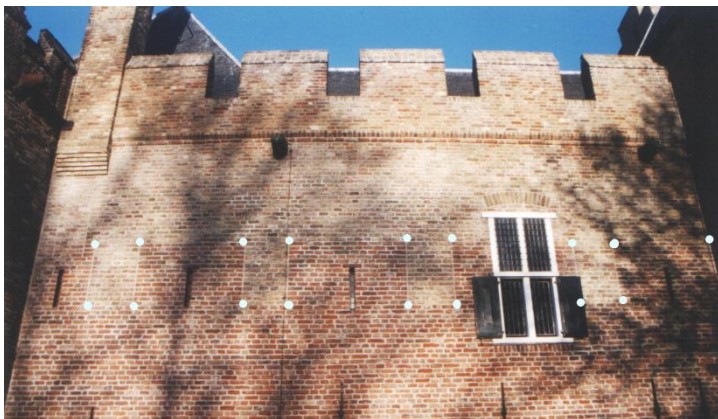
Afb. 12. De vermeende oorspronkelijke lage weermuur met kanteling (witte stippen) en schietgaten, volgens J.Holstein, zijn tijdens de laatste restauratie, in het metselwerk geaccentueerd. (Foto: Ben Dijkhuis)
