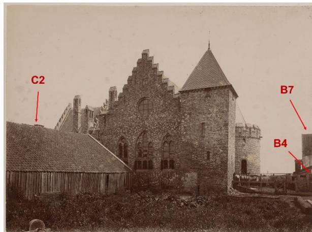
Afbeelding 14 Foto van de noordwestzijde van het kasteel uit 1898. Hierop ziet men de houtloods C2. Rechts een deel van de bebouwing aan de westzijde van het slot. Bron: beeldbank NHA, objectnr. 559-004052.
