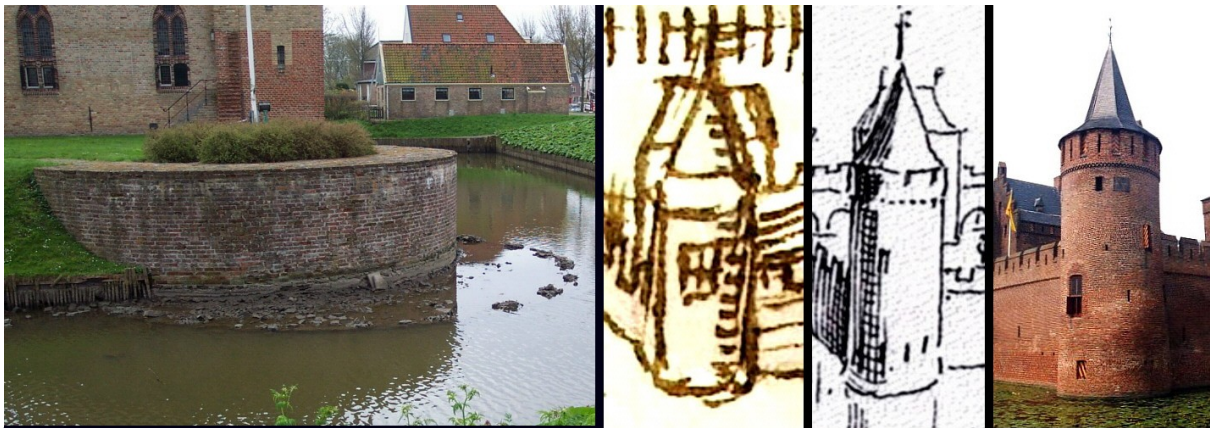
Afb. 2. Links het fundament van de Molkentoren ter hoogte van de waterlijn. Daarnaast de enige bekende afbeelding van de Molkentoren op de belegeringskaart van 1588. Midden-rechts: een reconstructie door Victor de Stuers uit 1890. Rechts de zuidwestelijke toren van het Muiderslot met overkapte kantelen, die model stond voor de reconstructie op afb. 1.
