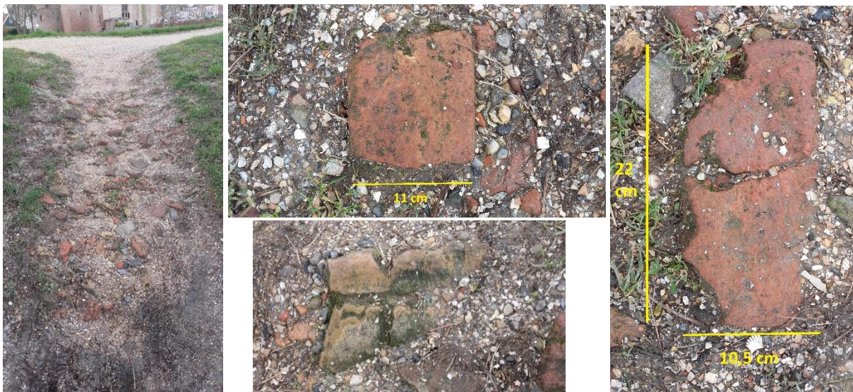
Afbeelding 4 Divers steenpuin in het dijklichaam van de Oosterdijk, ten oosten van het kasteel (deels te zien op de achtergrond van de linkerfoto). Hierop ziet men rode bakstenen. Het is niet uitgesloten dat dit puin afkomstig is van het buitendijks land, tijdens de dijkophoging in 1666. Foto's van de auteur.
