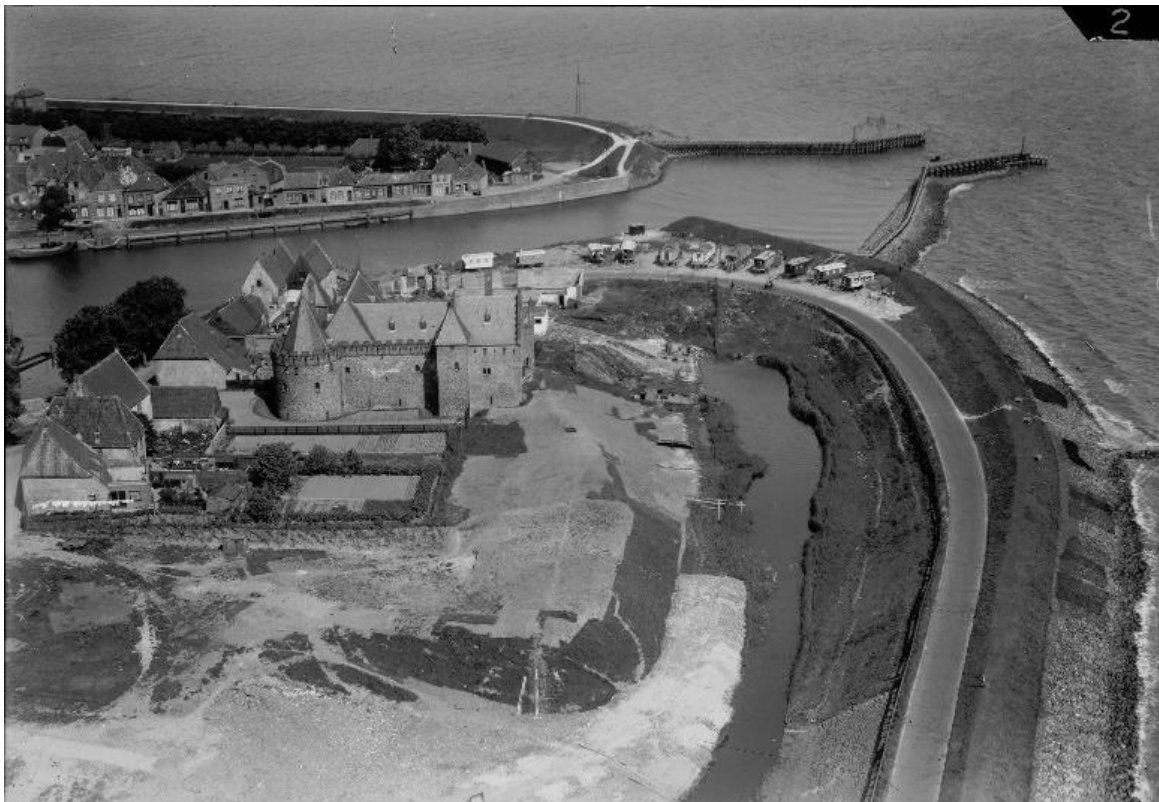
Figuur 2. Werkzaamheden in de periode 1937/38 tijdens het uitgraven van de slotgracht. De bodem aan de oostzijde is zwaar verstoord. Met name het zichtbaar ontbreken van de oostelijke torenfunderingen.
